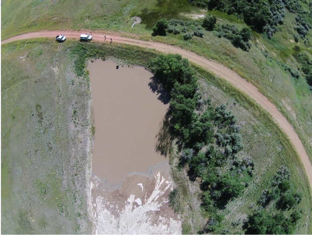
23. Sediment Pond (SP2)
