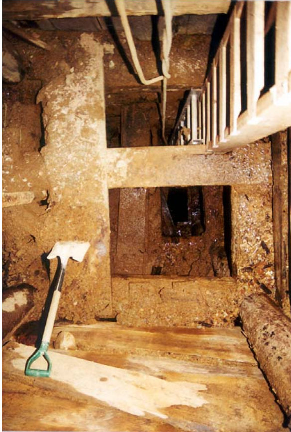
Figure 4. Glengarry Mine Two Compartment Como Raise
