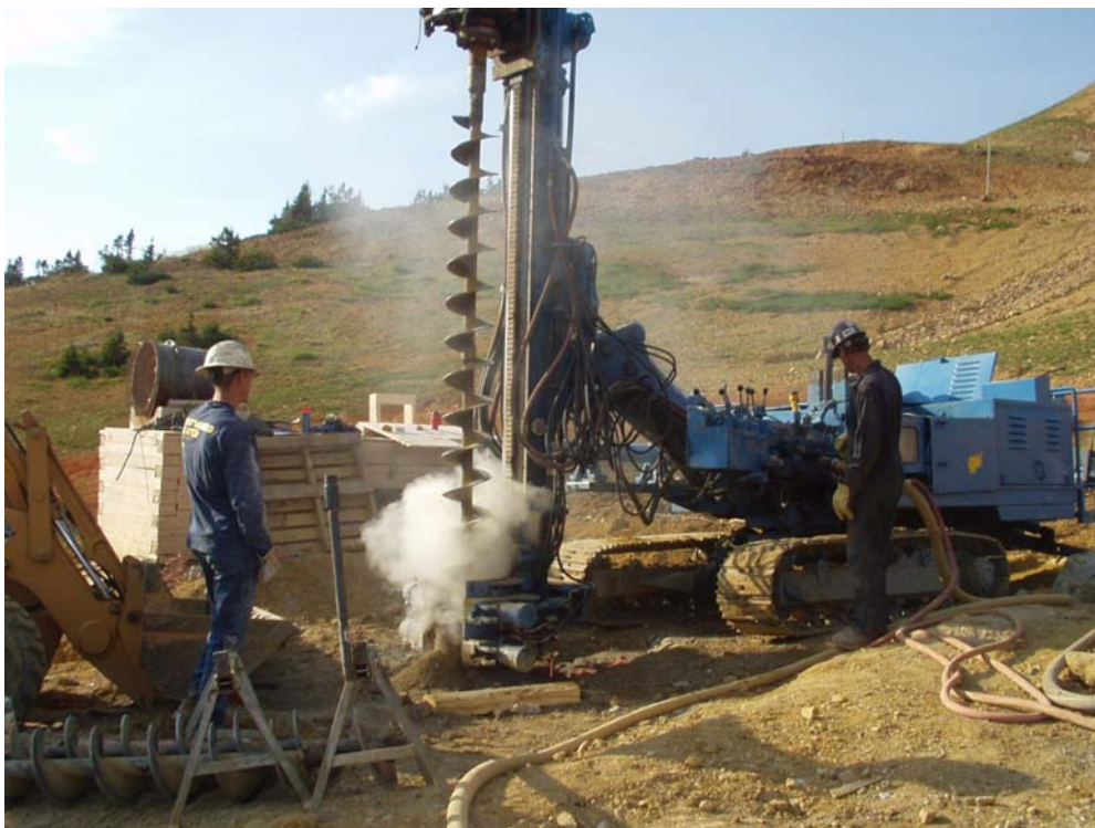
Figure 13. Como Raise Collar Auger Holes for Caisson Wall
