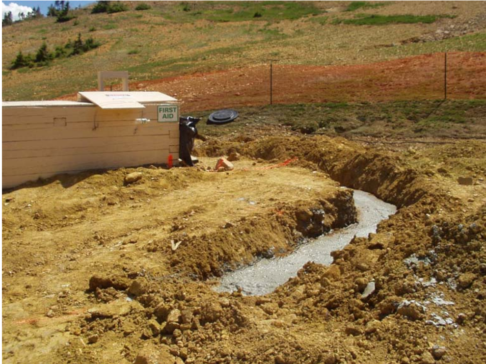
Figure 12. Como Raise Collar Grout Trench
